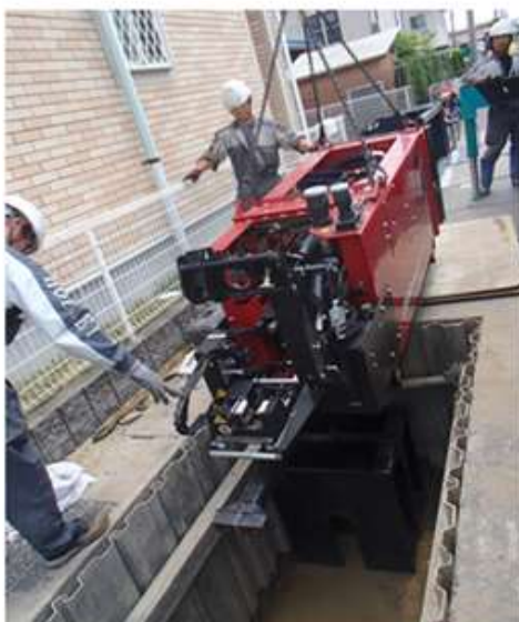
機械据付状況
