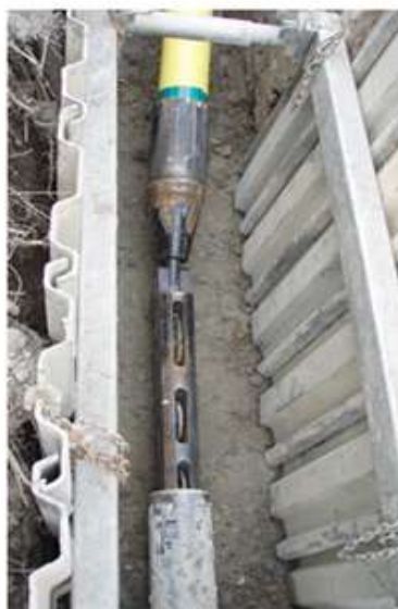
治具取付状況
